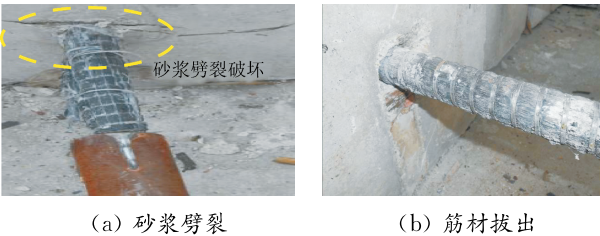
(a) 砂浆劈裂 (b) 筋材拔出 图 2 试件破坏形式图 Fig. 2 Failure modes of specimens
